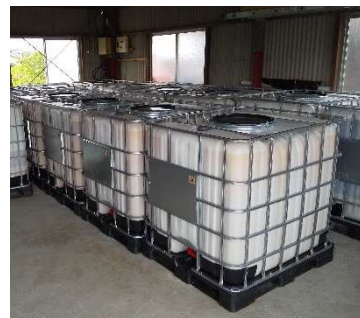
発酵・貯留タンク
